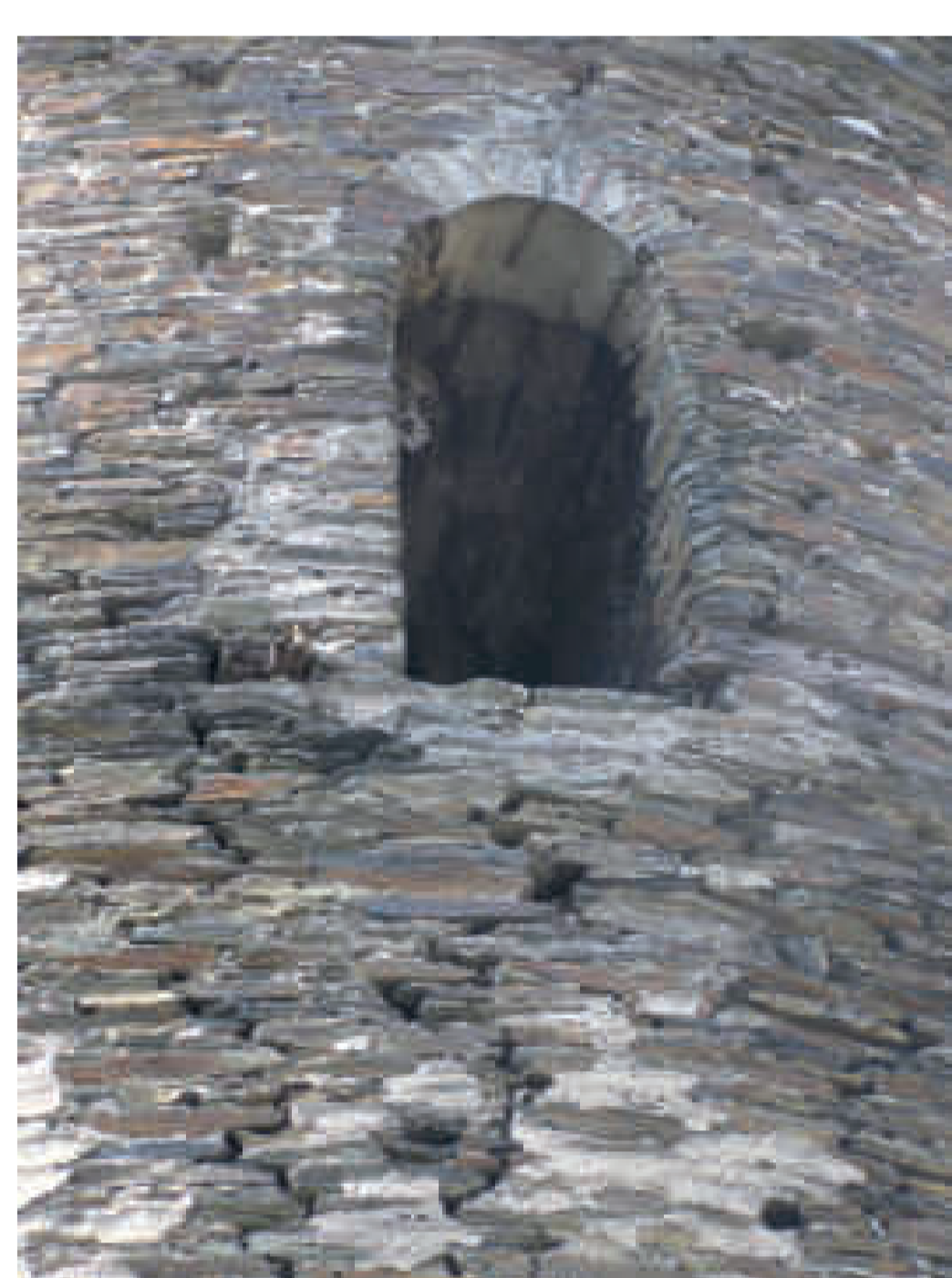
Burgruine Stahlberg; Eingang zum runden Bergfried in neun Metern Höhe. Aus dem Balken rechts unten wurde die Probe zur dendrochronologischen Untersuchung genommen.
